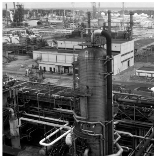
Industrial Refineria pemex - Ciudad Madero
